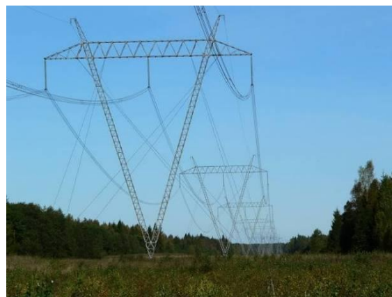
Рис.3. Схема опори ВЛ на оттяжках
